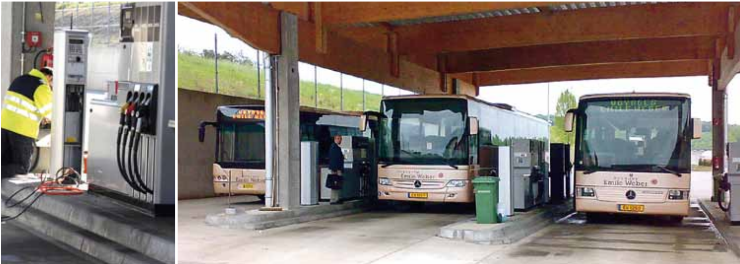
Die Tankanlage des Busunternehmens Weber in Canach (Luxemburg) bekommt den letzten Feinschliff (l.), bevor der moderne Betrieb startet (r).
